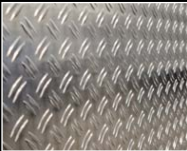
Bodenplatte mit Aluriffelblech belegt
